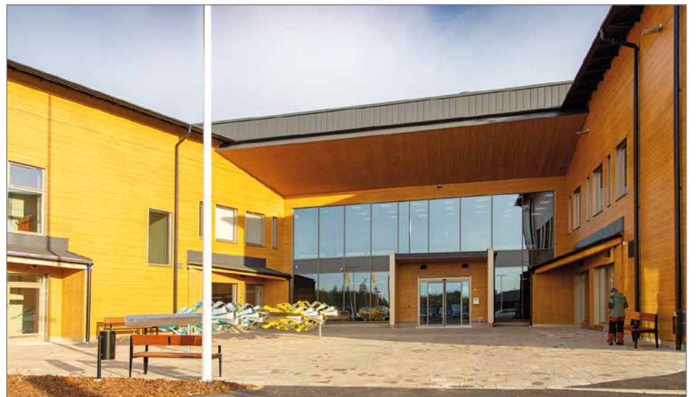
Julkiset palvelut kulttuurista ja terveydenhuollosta varhaiskasvatukseen, koulutukseen ja ikäihmisten asumiseen ovat Pudasjärvellä uusissa hirsirakennuksissa. Hyvän olon keskus Pirtti, pääovi. (Kuva: Juha Nyman).
