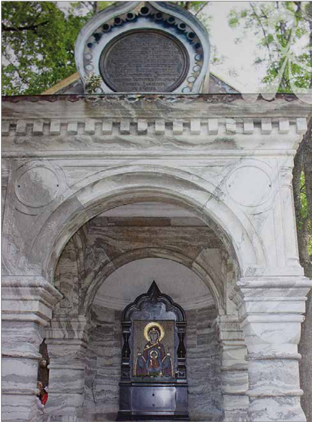
Znamenie- eli ennusmerkki-ikonille rakennettu kappeli rakennettiin Aleksanteri II:n Valamon vierailun kunniaksi vuonna 1858.
