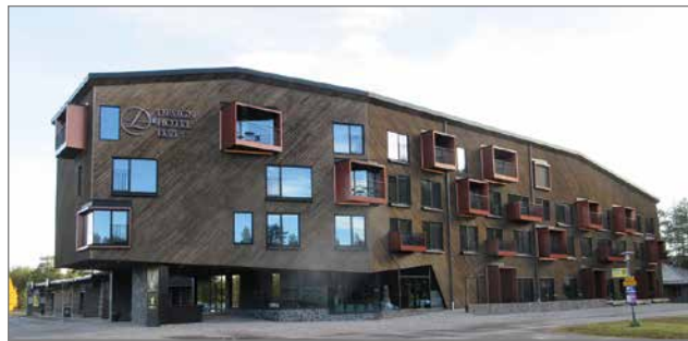
Reilut kaksi vuotta sitten valmistunut Design Hotel Levi ravintoloinen, kylpylä ja erilliset majoitusrakennukset ovat suuri matkailukokonaisuus Levillä.
