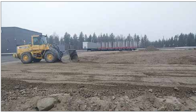
Marraskuun alussa täyttömaita tasoitettiin tulevaan rekkaparkin alueelle. Kuva: Pirkka Ylikoski.
