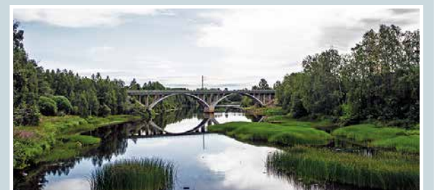
Kuivajoen silta. Kuva: Mauri Hietala.
