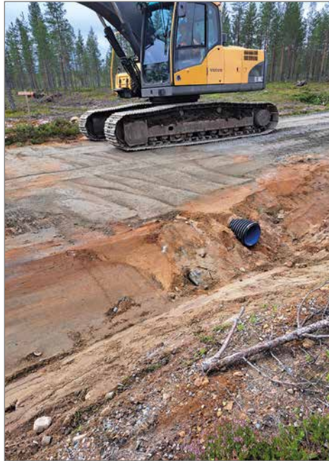
Repovaaran kohdalle lisättiin putkirumpu.
