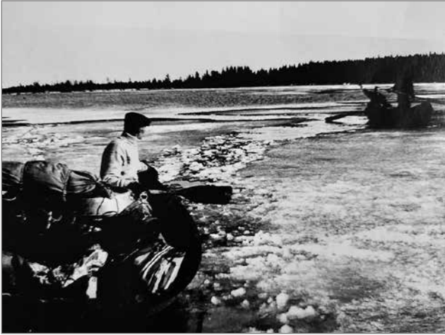
- Purouitot piti aloittaa hyvissä ajoin, jotta pääuomaan päästiin ajoissa. Keväällä räjäytimme jäitä, että pääsimme eteenpäin, silloin söimme hyvin kalaa, muisteli Juhani.
