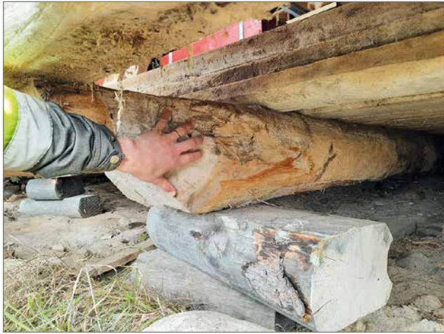
Paksua on puu ennen ollut. Ennen kengitystä opiskelijat tunkkivat ja tukivat niskat väliaikaisesti.
