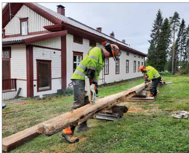
Vanha hirsi oli tiukkasyistä. Pintasiivun sahaamiseen meni aikaa kolme tuntia. Vanhan ajan sepän tekemät rautanaulat toivat oman haasteensa. Niitä piti katkoa puukkosalhalla.
