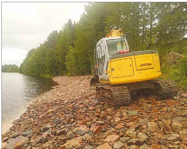
Tela-alustaisella kaivurilla pääsee liikkumaan vaivattomasti erilaisissa maastoissa.
