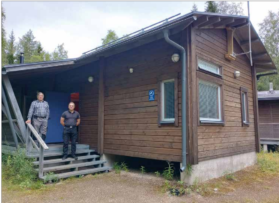
Pekka Niemitalo on autellut poikaansa Antti Niemitaloa Myllytuvan remontissa mm. Ilmalämpöpumpun asennuksessa.
