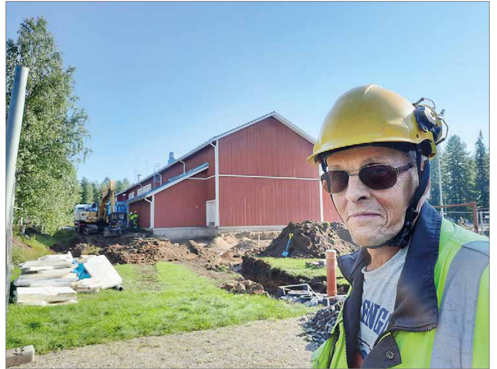
Kauko Määtän tehtävä on valvoa yleisen turvallisuuden toteutumista työmaalla.
