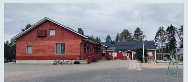
Kipinän koulu on saanut laajennusosan ja paljon Aittojärven lakkautetun koulun pihapiiristä tuotuja ulkoliikuntavälineitä.
