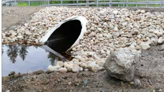
Siltaputki on polymeeripinnoitettu sinkitty kierresaumattu teräsputki, jonka käyttöikä on 100 vuotta.
