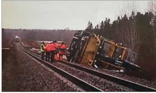
- Teksteri-työkone meni kumolleen, kun laskettiin viimeistä suurta pylväselementtiä ratakiskon varteen. Kukaan ei onneksi loukkaantunut eikä työnjohtajat moittineet meitä vahingosta.
