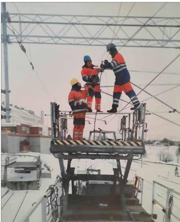
Rovaniemen ratapihalla ajolangan ja paluujohtimen asennustöissä, vas. Jouko Koivuaho, Esa Huovinen ja Tapio Sirkkiä.
