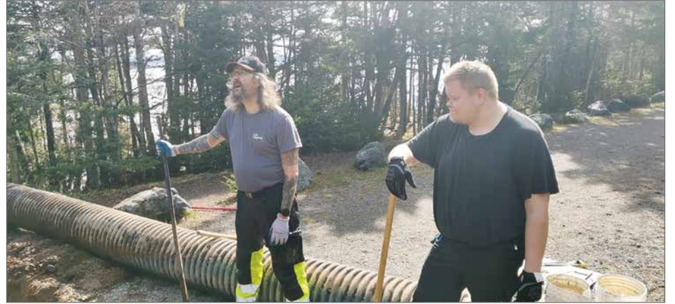
Jukka ja Jussi Kolu luonnonpuiston korjaustöissä. Rumpuputken kaivanto on saatu kaivettua auki.
