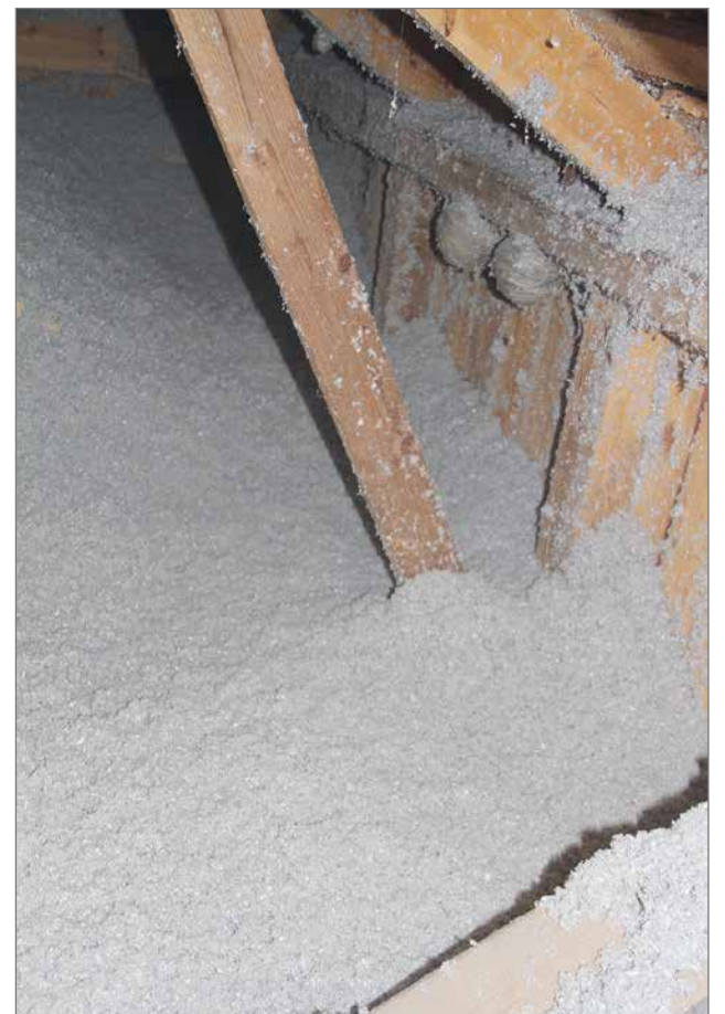
Sahanpurujen päälle laskettua villaa tuli kauttaaltaan noin 30–40 senttimetriä.
