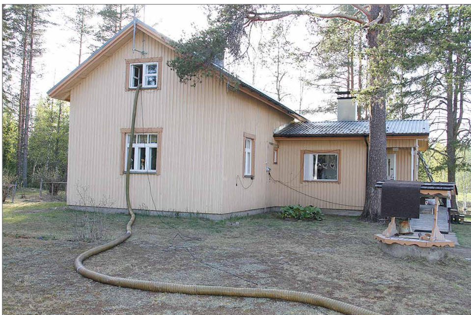
Rintamamiestalon ullakon poskitiloihin puhallusletku vietiin vintin ikkunan kautta.
