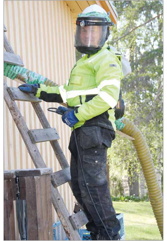
Suojaukset ja työturvallisuus on urakoitsijalla kodillaan. Karhumaa kiipesi ensimmäisenä lisäsiiven vintille.
