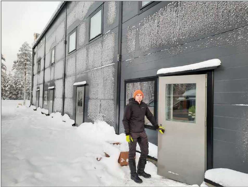
Rakennusvaiheessa on kuunneltu tulevien yrittäjien tilatoiveita.
