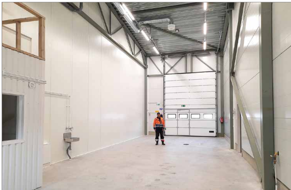
Hallin leveys on kuusi metriä. Tila näyttää nyt avaralta, mutta huoltoon tulevan rekan nuppi täyttää tilan melko tarkkaan. Lisäksi tilaa vievät työkalukäryt, öljysäiliöt ja muut laitteet, joita tarvitaan remonttihommissa.
