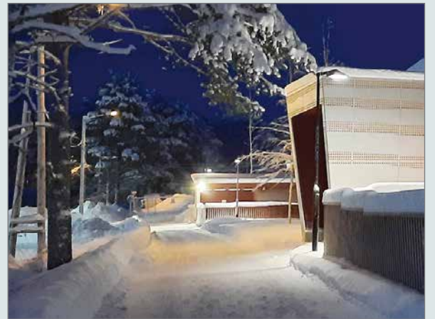
Sulkualueen kohdalla sijaitsee Vanhusten talojen uudelleenrakentamistyömaa.
