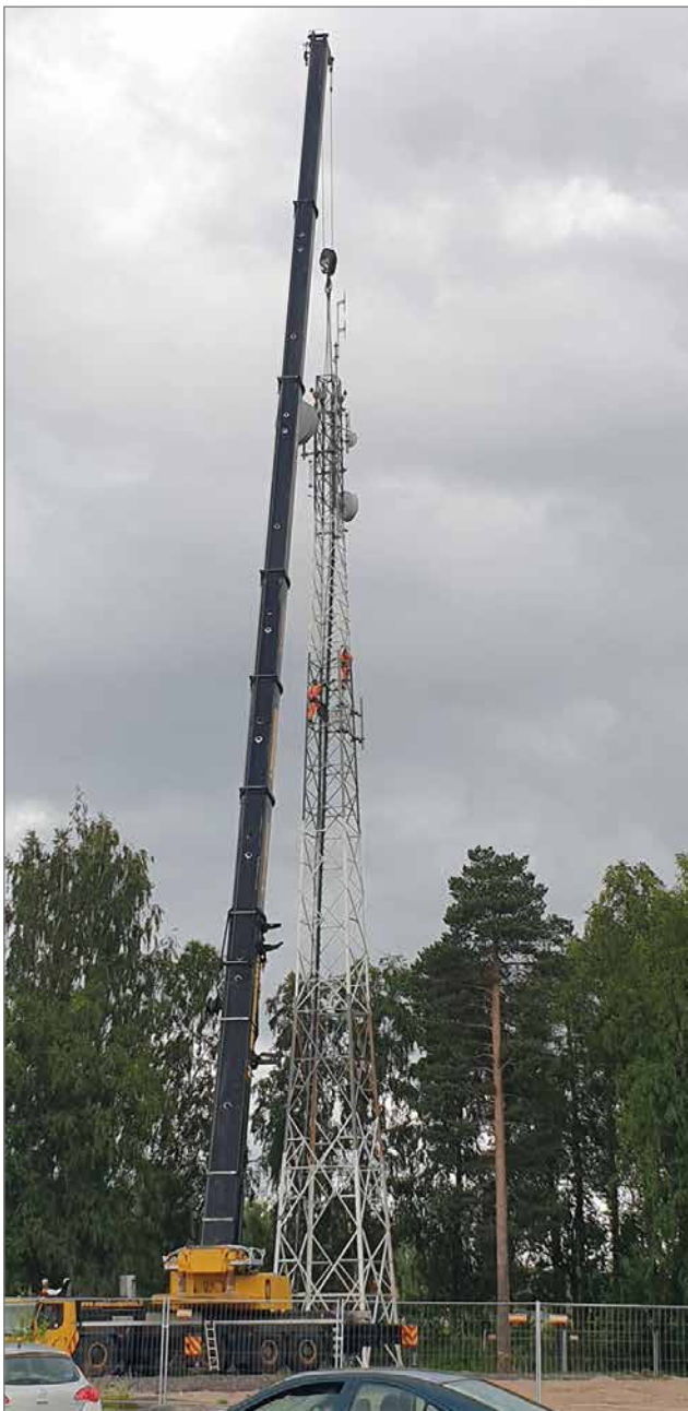
Koillis-Pohjan Sähkö Oy:n viimeisen maamerkin poisto. Yrityksen sisäisen kaukokäyttöverkon avulla pystytettiin valvomaan ja korjaamaan kaukana sijaitsevan sähköaseman toimintahäiriöt. Kuva: Veijo Mäntykenttä.
