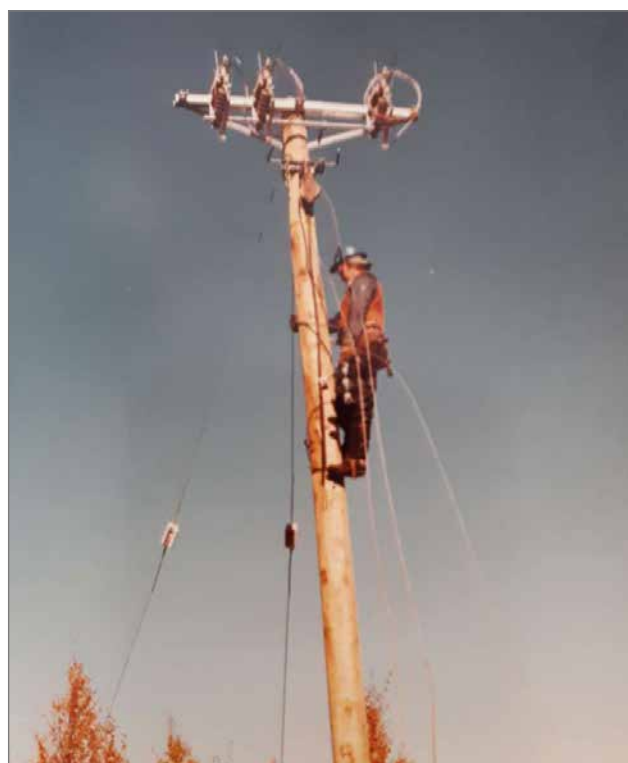
20 kilovoltin erottimen asentamista. Asentajien työskentelyolosuhteet vaihtelivat poutakelistä koviin pakkasiin. Aluksi asentajat työskentelivät omissa vaatteissaan, mutta melko pian työnantaja hommasi asianmukaiset kesä- ja talvityövaatteet. Kuva: Reijo Talala.
