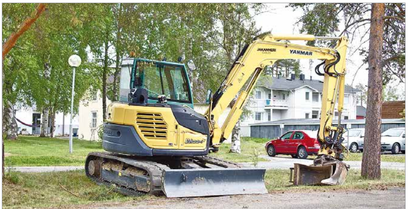
Kaivuutyöt ovat käynnissä Iin keskustassa.
