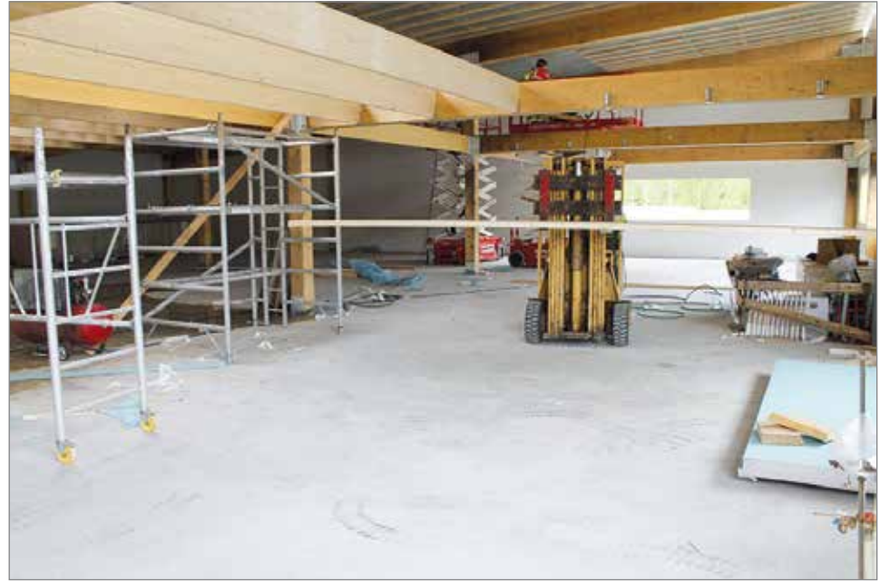
Rakentamistyömaalla on kyltti huoltoaseman avaamisesta syyskuussa, mutta tavoitteena on avata jo elokuussa.
