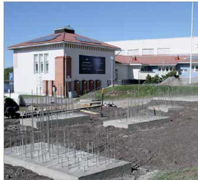
Rakennusvaiheessa olevaa teosta voisi äkkiseltään luulla tavalliseksi työmaaksi.
