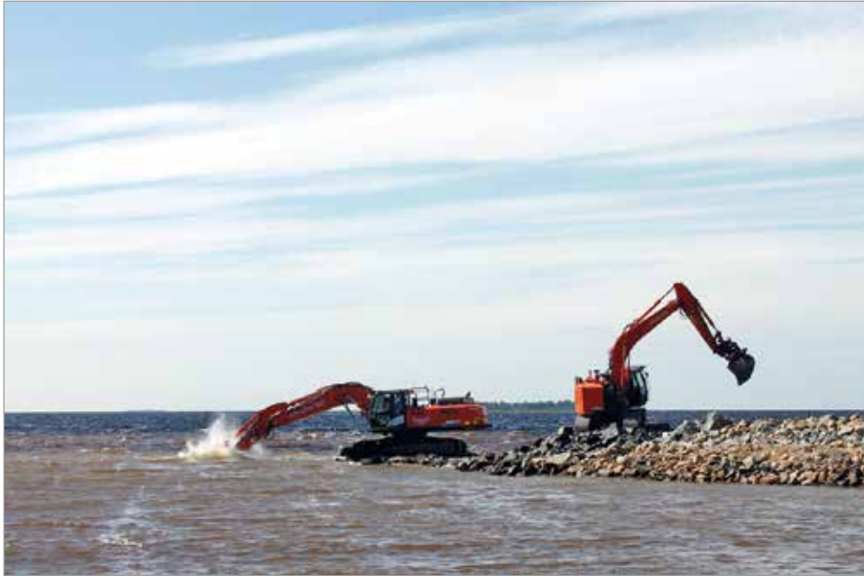
Vatungin satama-altaan aukkoa laajennettiin juhannuksen jälkeen, jotta suuremmatkin kasvatusaltaat mahtuu tuomaan satama-alueelle. Kuva Jenny Kärki
