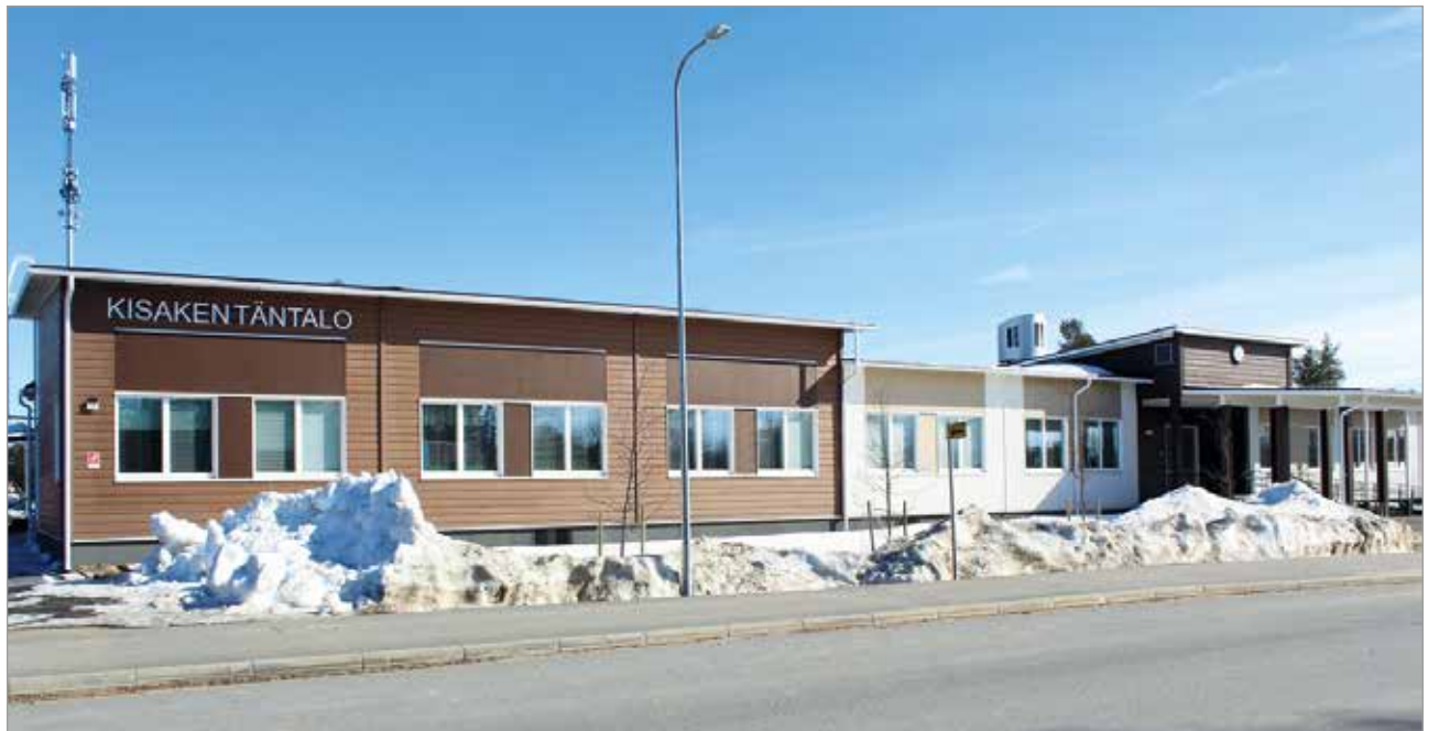
Kisakentätalo nimen saanut koulukiinteistö sijaitsee Valtarintien ja Kangastien risteyksessä. Valtarintien puolella opiskelee Haminan ja Alarannan koulujen oppilaita. Lukio sijoittuu Kisakentätalon Kangastien varrella olevaan osaan.
