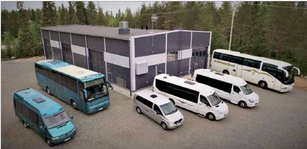
K.Hekkanen Oy:n uudet toimitilat Simon Asemakylällä.
