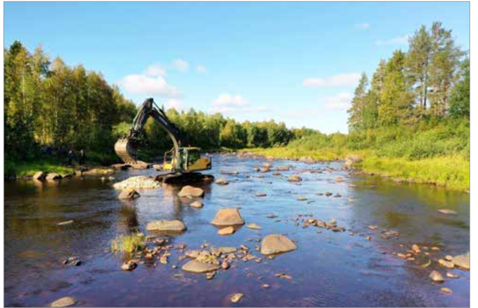
Koskien kunnostamista Näsiönkoskella. Kuva: Eero Dahl.
