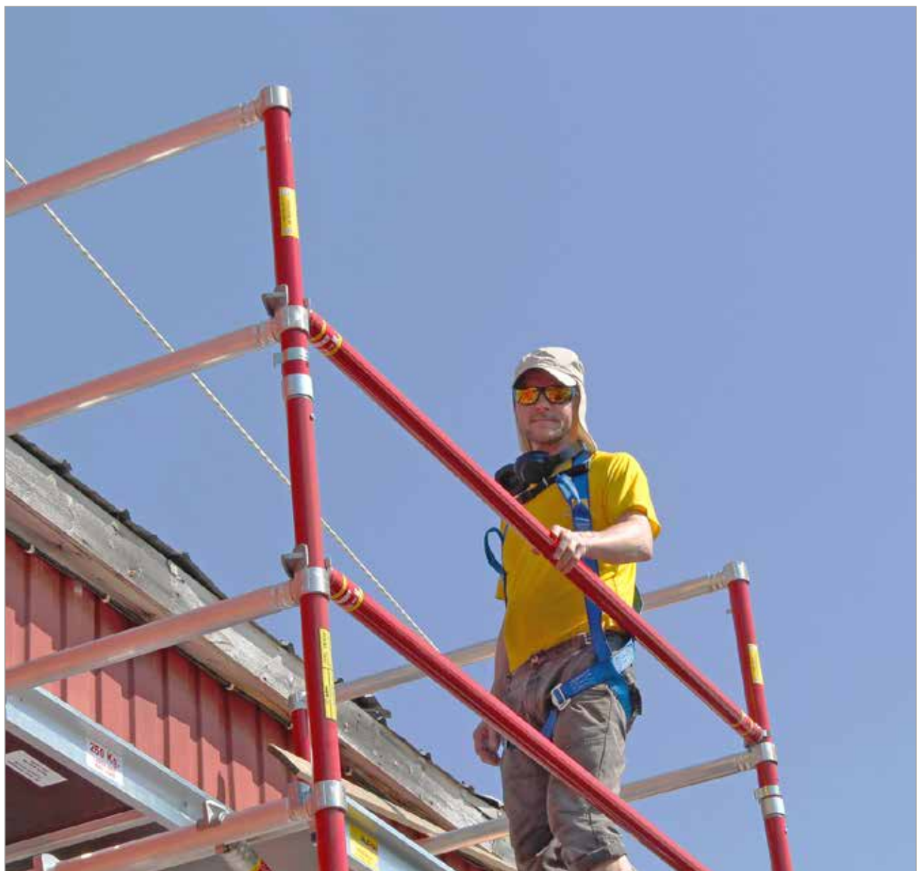
Polar Works Monipalvelu Oy:n yrittäjä Kari Meriläinen on tämän kesän kiireinen hallirakennuksen kattourakan parissa.
