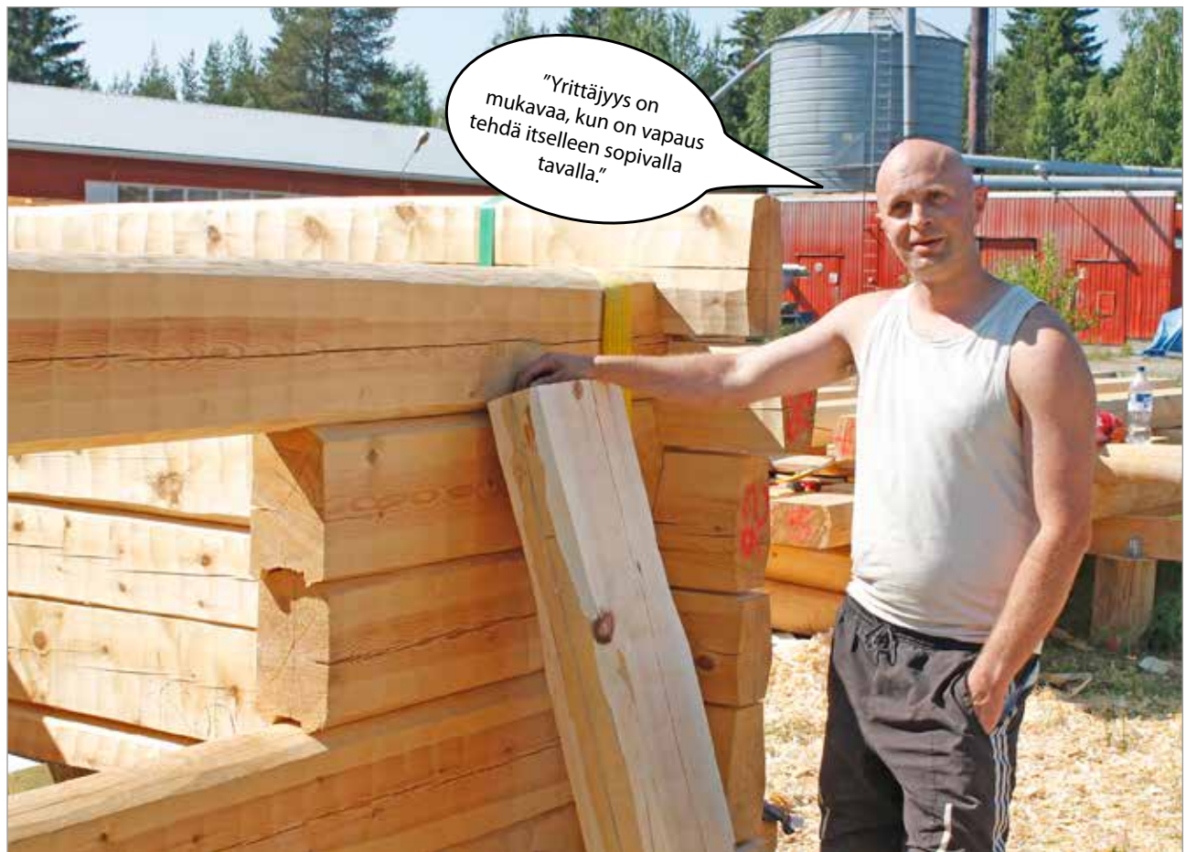
Juha Ravela veistää ja rakentaa hirsikehikot valmiiksi Kuivaniemellä, jotka sitten kuljetetaan asiakkaan pihaan koottaviksi.
