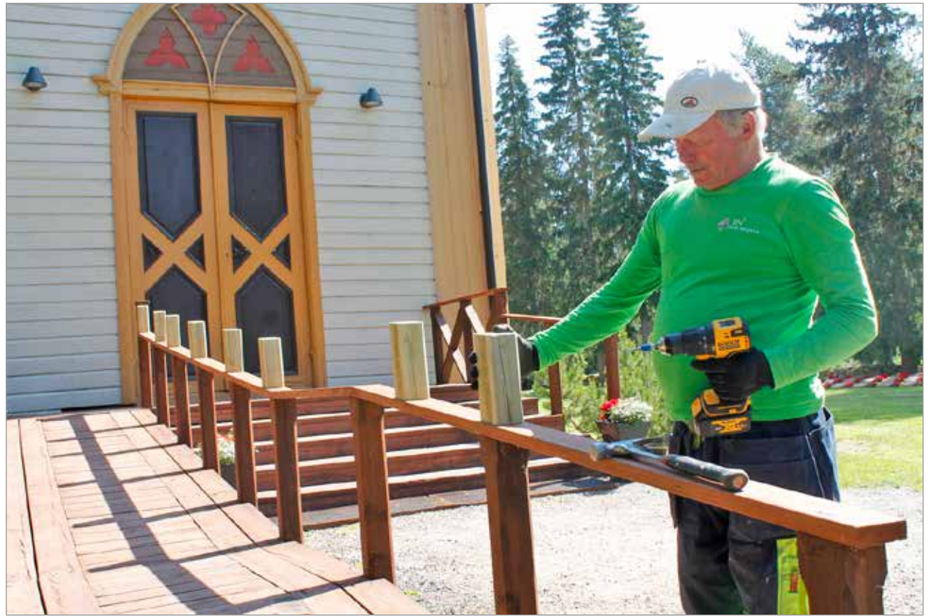
Kesäkuun lopulla seurakunnan jokapaikanhöylä Kauko Juopperi oli rakentamassa Kuivaniemen kirkon pyörätuolirampin kaiteeseen korotusta, jotta myös huonompijalkaisten kävelijöiden on helpompi ottaa kaiteesta tukea.
