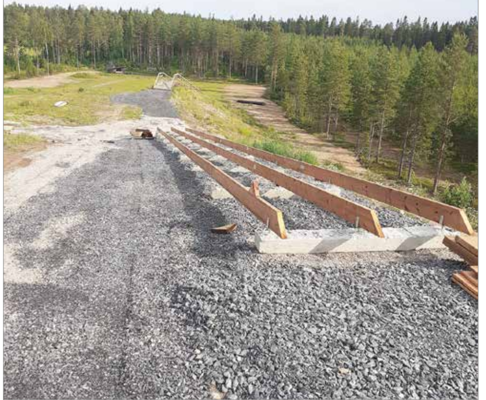
Olemassa olevat kuntoportaat saavat reilusti lisää pituutta uusilla portailla.
