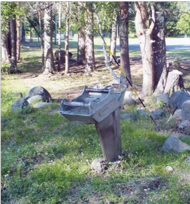
Parhaimmissa tapauksissa valokuitu voitiin aurata maahan, eikä jälkiä juurikaan jäänyt.
