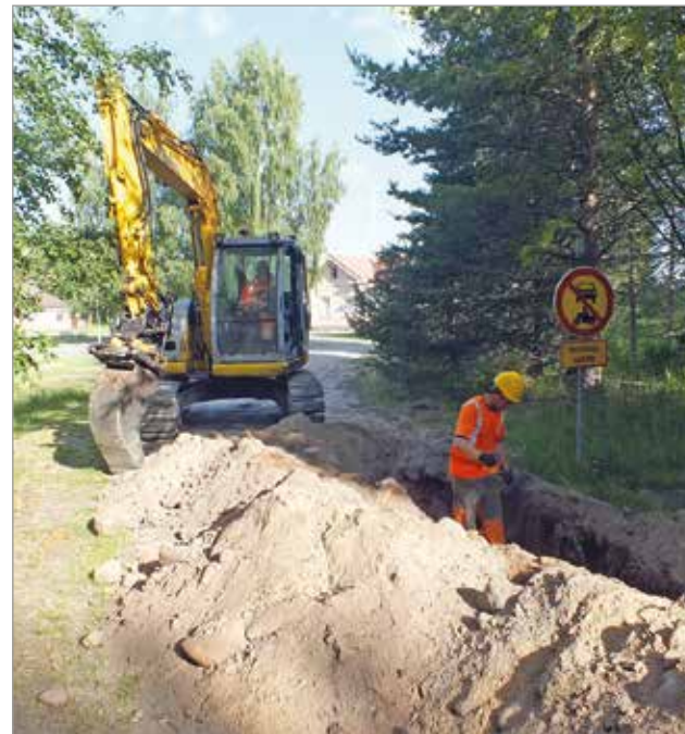
Suurin osa kaapeleita kaivettiin maastoon ja jäljet siistiin.
